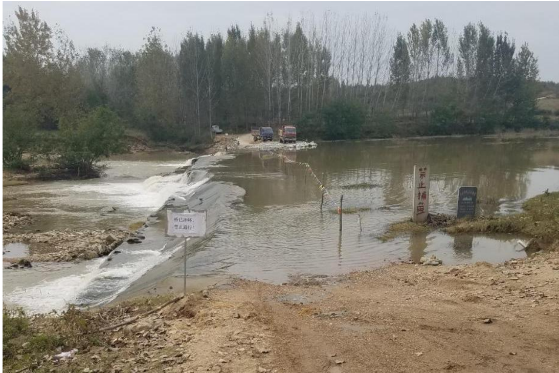
图2.3-2 厉山镇车水沟村过路漫水桥
